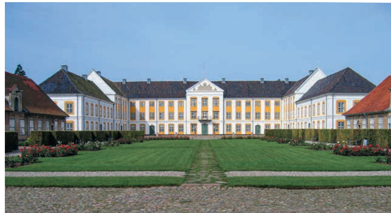
I 1760'erne og ind i 1770'erne opførtes det nuværende Augustenborg Slot, som her ses fra porthuset hen over ridebanen og slotsgården. Til venstre ses herskabsstalden, der i 1733 indledte byggeriet, mens ridehuset overfor, der også rummede godskontor, tjenerværelser og snart hertugens bibliotek, stod færdigt i 1764. Andre af hoffets ansatte boede i bygninger som vaske- og køkkenhuset med flere steder, atter andre på selve slottet. Foto: Museum Sønderjylland.
