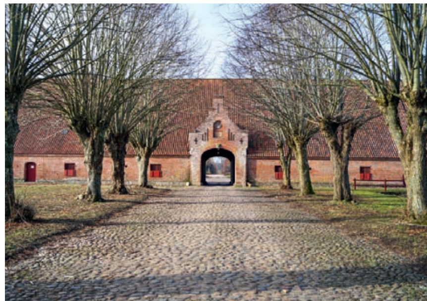
Agerumsladen på Bidstrup Gods er en stor del af det samlede herregårdsanlæg. Agerumsladen har mange værdier, blandt andet portgennemgangen med kamtakkede gavle, der markerer indgangen til det samlede anlæg. Foto: Karina Beck.
