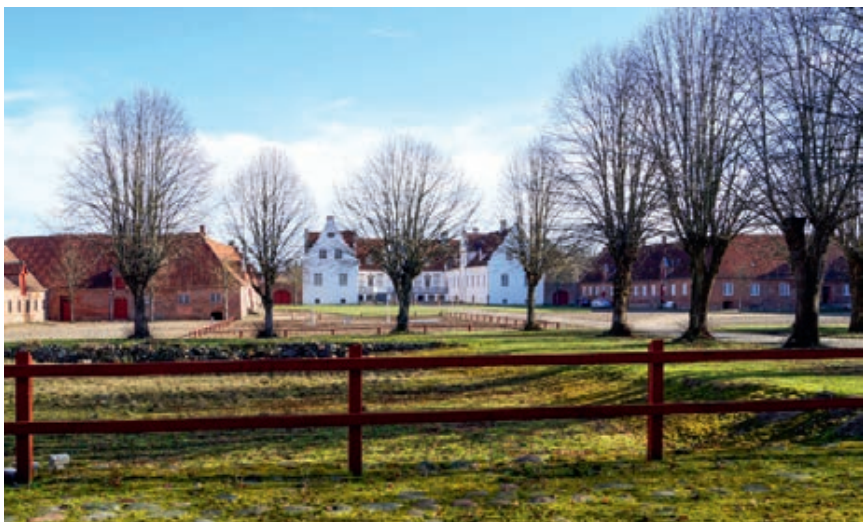
På Bidstrup Gods tildeles det samlede anlæg stor værdi. Her underordner avlsbygningernes simple udtryk sig hovedbygningens mere dekorative ydre, som derfor kommer yderligere i fokus. På billedet ses blandt andet hovedbygningens vælske gavle, mens også smedejernsgitteret på balkonen kan anes. Foto: Karina Beck.
