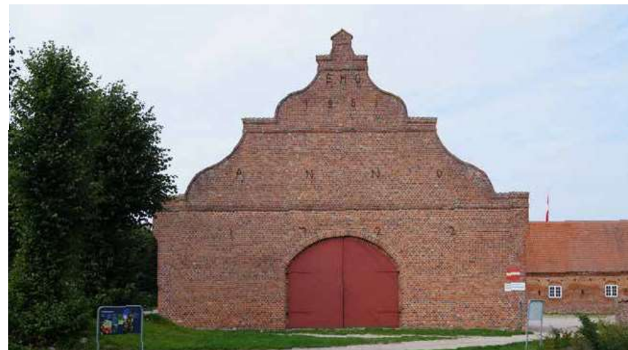
Ridehuset var en del af de byggerier, som det unge adelspar foretog, da de flyttede til Gammel Estrup. Ridehuset udgør den sydligste længe i avlsbygningerne og bærer både Christens og Augustas initialer samt årstallet 1722. Ridehuset er endvidere nævnt i godssregnskaberne fra december samme år. Bygningen blev beskadiget under en stor brand i 1949, og årstallet 1951 og initialerne EHG refererer således til dette og den daværende godsejer, Ebbe Holck Gregersen. Foto: Gammel Estrup Danmarks Hærregårdsmuseum.
