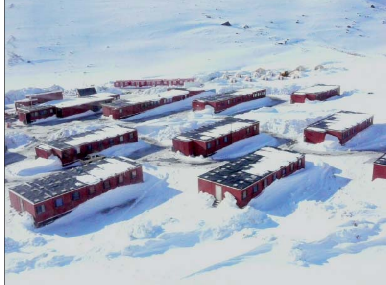
Nalunaq-lejren en vinterdag. I baggrunden ses den gamle teltlej, som stadig benyttes og 10 containere hver indrettet med 2 værelser og fælles bad. (Foto: Nalunaq Gold Mine A/S)
