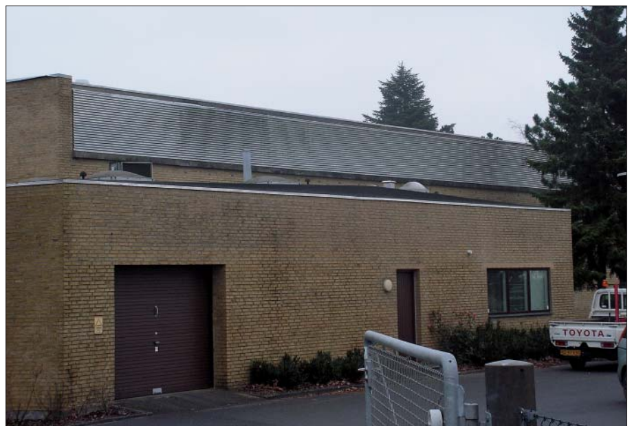
Højballegårdværket (1970) i Horsens er bygget i traditionel stil med iltningstrappe og dobbeltfiltrering på åbne filtre. Vandværket behandler 1.000 - 2.000 år gammelt grundvand og er det største vandværk uden for Københavnsområdet. (Foto: UVH)
