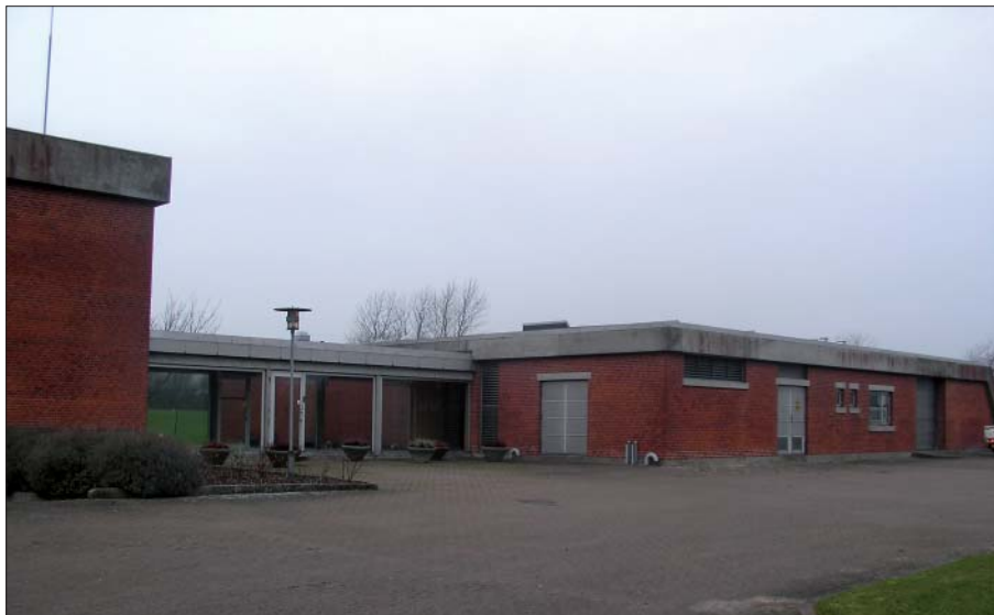
Rugballegårdværket (1976) i Horsens er placeret i et industriområde, hvorfor vandbehandlingens sker i et lukket kredsløb, hvor der benyttes ren oxygen til iltning af vandet. Herefter dobbeltfiltreres det iltede vand på høje lukkede filtre. Vandværket behandler grundvand, der er henholdsvis ca. 1.000 og 1.200 år gammelt fra to forskellige grundvandsmagasiner. (Foto: Ulla V. Hjuler)
