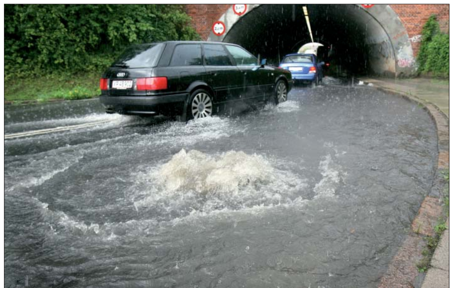
Oversvømmelse i Odense, august 2006. (Foto: Niels Mogensen Svalebøgg)
