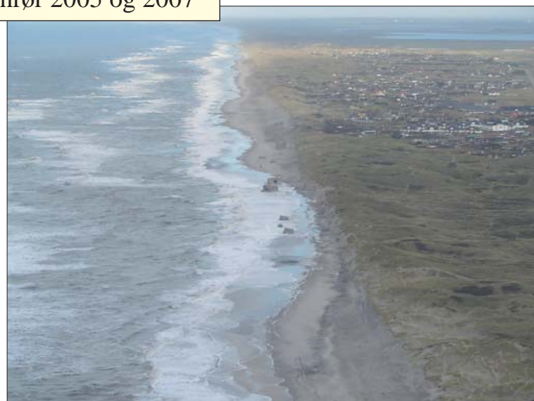
Søndervig d. 16 januar 2007 efter en investering på 42,0 mio. kr. i strand- og revlefodring. Strandfodringen er skyllet i havet, og havet har taget ca. 400.000 m 3 af klitterne. Vandstand: +50 cm. (Foto: P. Jakobsen)
