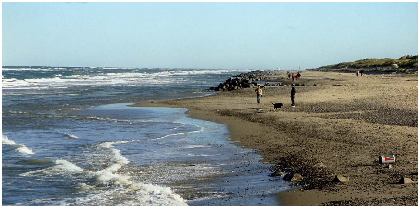
Man ser meget tydeligt højdevirkningen ud for rækken af trykudligningsmoduler ved Gl. Skagen. (Foto: Poul Jakobsen 1999)
