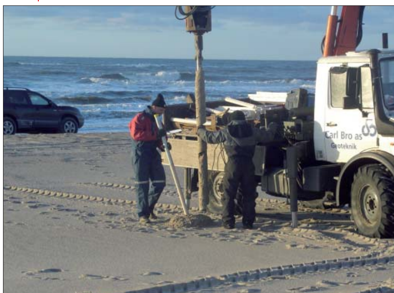
Trykkudligningsmodulerne bores ned i stranden og sættes ca. 25 cm under overfladen. (Foto: Poul Jakobsen)
