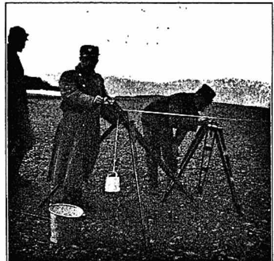
Spændbuk med Lod til Spænding af Maaletræden. Afmåling for Mærkebukken.
