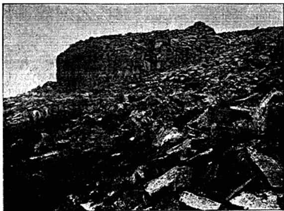
Borgarvirki. Det sydvestre Hjørne med Adgangen ( d ). (Efter Fotografi.)
