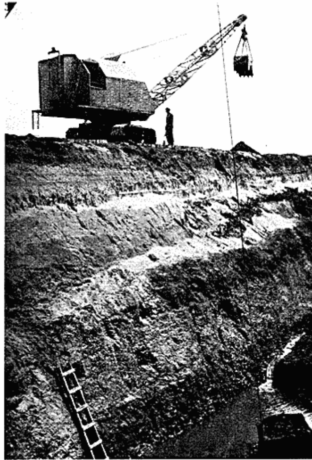
Fig. 3. Stærk Tilstrømning af Grundvand, Over Vandfladen ses et Brunkulslag, derefter et lysere Lag med Glimmerler, eller Brunkul, derover tertiært Sand, og øverst Istidssand. Fra Søby-Lejet.
