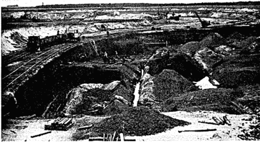
Fig. 5. Overjorden fjernes her med Tipvogne i Sommerhalvaaret, mens Vinteren er Højsæson for Brydning af selve Brunkullene.
