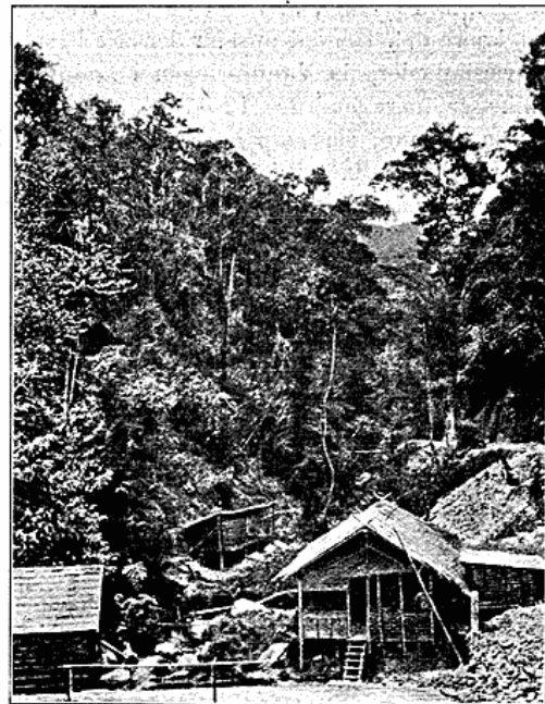
Fig. 7. Materialskur i Urskoven. Sumatra. Til højre foran den paabegyndte Ledning.
