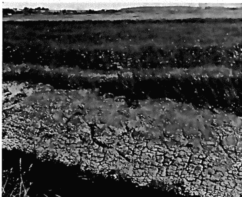
Fig. 1. En af de nygravede sidekanaler til hovedkanalen. Ved tørringen er det frilagte dynd blevet hårdt og har slået store revner.
