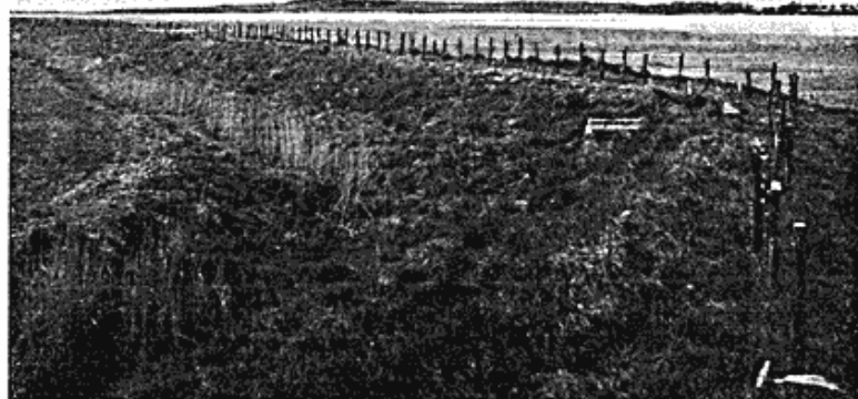
Fig. 6 Dæmningen ved Fladstrand Vest for Vejlo By. I Dæmningens „Knæk“ (t.h.) ses Resterne af den gamle Pumpes- stations Vand- snegl. I Bag- grunden Gavnø med Skov.
