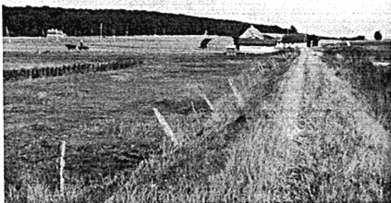
Fig. 8. Hoveddæmningen ud mod Dybsø Fjord. Det inddæmmede Areal t.v.f. Dæmningen. Ved Dæmningen ses Pumpestationen og Nylandshuset. I Baggrunden Basnæs Skov.
