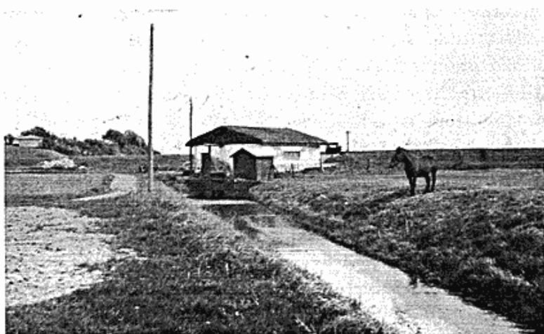
Fig. 10. Hovedkanal og Pumpestation i Nylandsmosen. Bag Hesten ses Dæmningen ud mod Dybsø Fjord.
