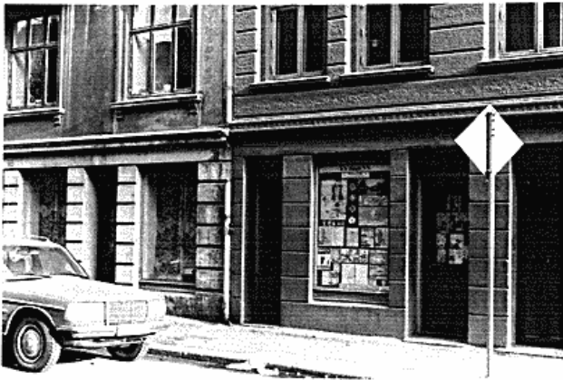
Fig. 14. I Nygårdsgaten er det ikke langt mellom bygninger med tomme leiligheter eller nedlagte butikker.
