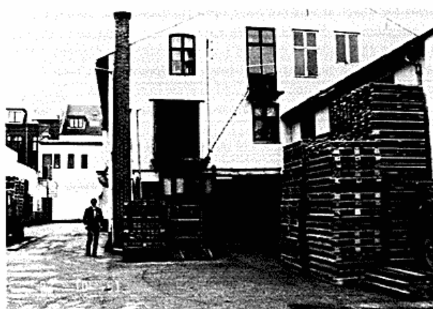
Fig. 1. En typisk baggårdserhvervsvirksomhed med bygninger i flere etager, vanskelige tilkørselsforhold og udendørs oplagring.
