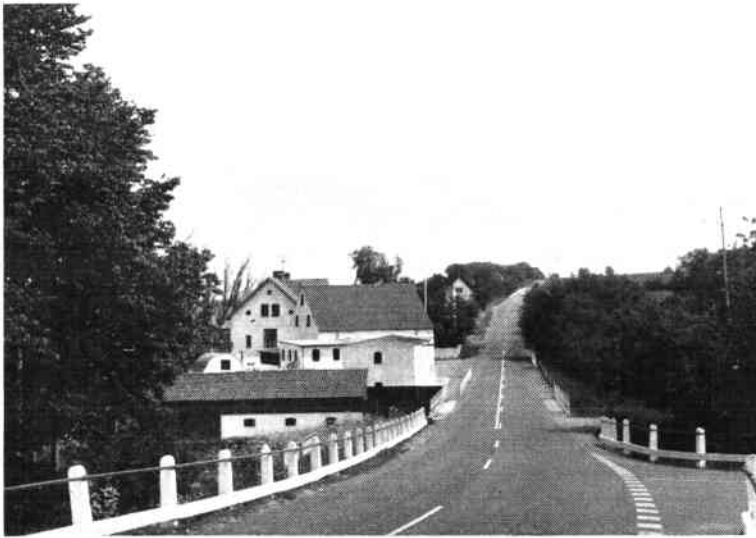
Fig. 11. Broen ved Fulbro Mølle. Vejen, der kommer fra højre på billedet er den gamle Horsens-Skanderborgvej. Billedet er typisk for, hvorledes de gamle vejbroer ser ud i vore dage. S.B. fot. 1966
