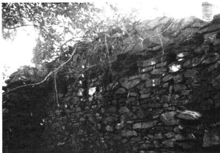
Fig. 11. Nordsiden af muren i værelse D på fig. 9 set indefra. Hullerne er til loftsbjælkerne. Det midterste hul over loftet går til et udvendigt tagudløb, hvorfra vand kunne opsamles fra det flade tag.
