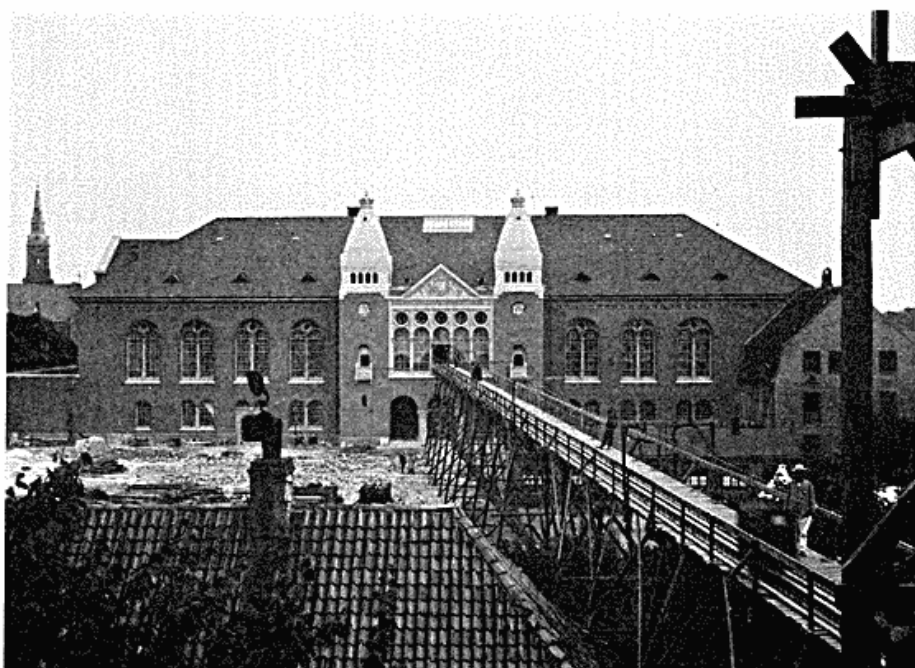
Broen hvorpå bogvognene 1906 kørte fra det gamle bibliotek, det nuværende Rigsarkiv, til den nye bygning.
