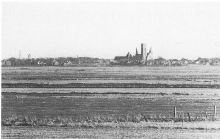
Fig. 5. Langs med Vadehavets kyst, ovenpå den gamle strandvold, byggedes i begyndelsen af vort århundrede det store havdige. Fra dets top kan man mod øst se de gamle randbebyggelser på geesten oven for den flade marsh, som her udfor den største af disse bebyggelser, byen Ribe. Foto: Hans Otzen.
