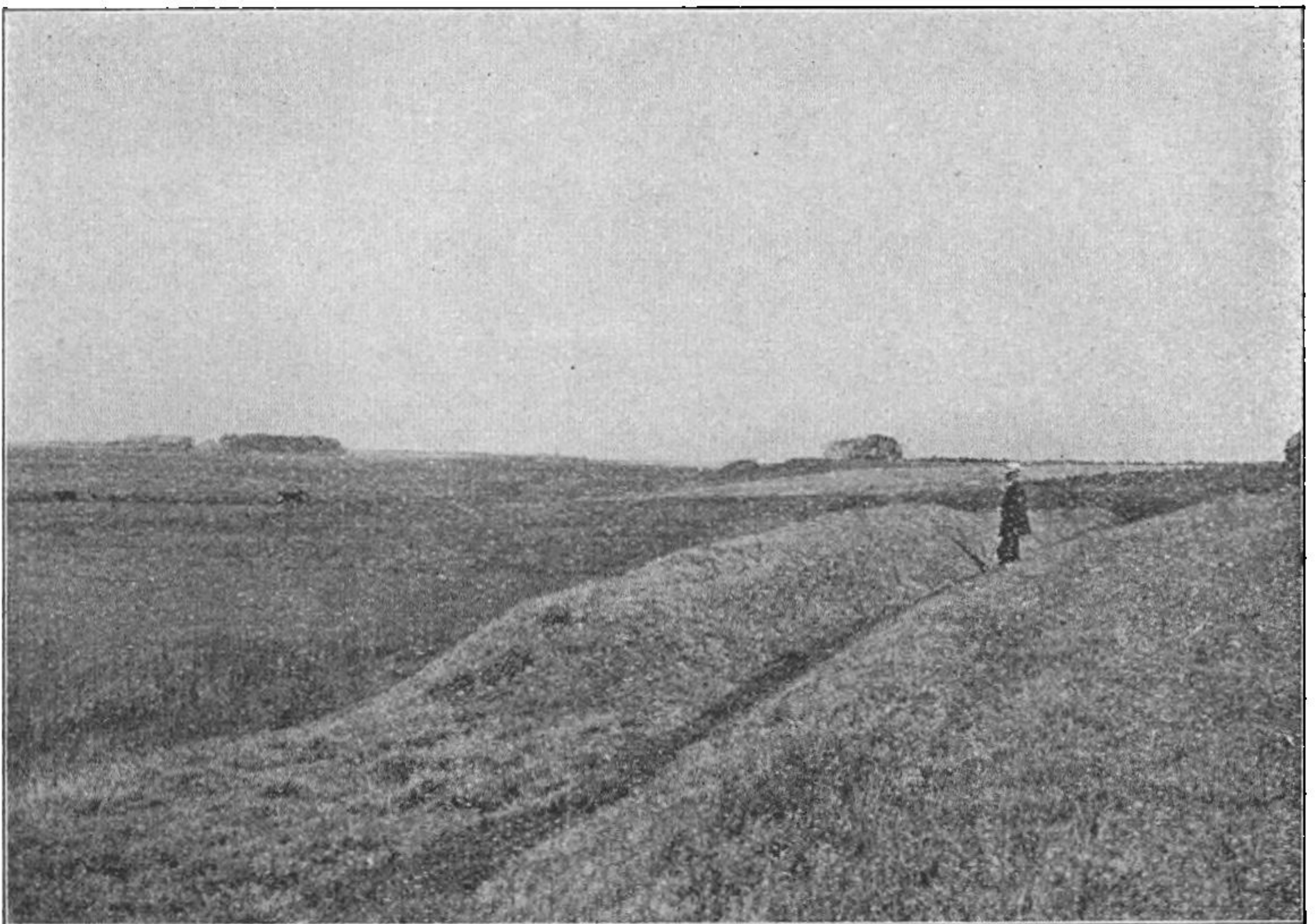
Forsvarsdige ved Varde Aa ved Gjellerupgaard.
