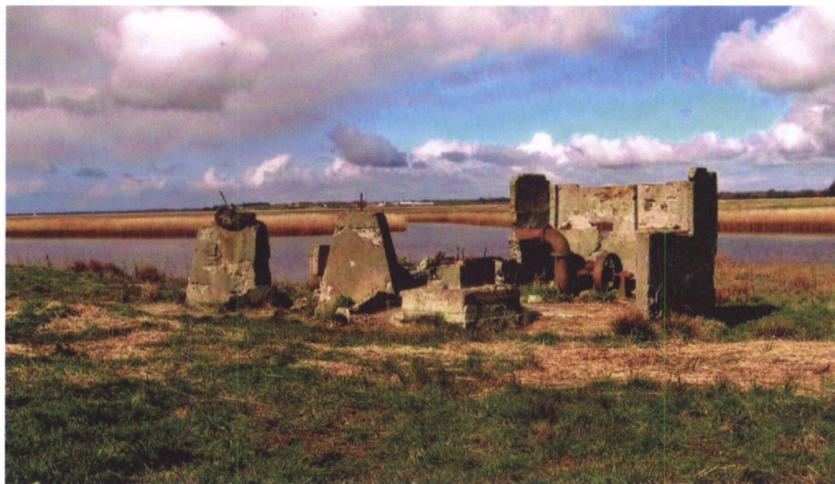
Rester efter pumpehus Visselbjerg enge (forfatteren 2011).
