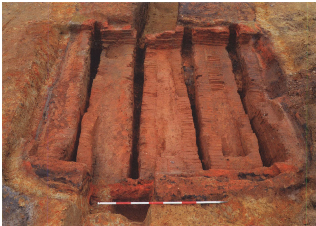
Figur 8. En fejlbrænding ses her blotlagt i en af ovnene. Stenene var aldrig blevet færdigbrændt og særligt stenene langs ovnens yderkanter var endnu helt bløde. Under denne portion teglsten lå de sidste levn af en tidligere fejlbrænding. Bemærk de fire åbninger i den tværgående teglmur. Øverst i billedet ses fyrområdet, hvor man har fyret med tørv. Foto: Museet på Sønderkov.
