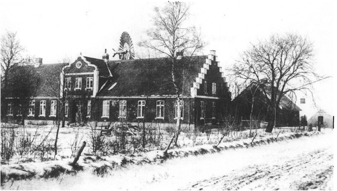
Seemgård, nye hovedbygning. Seemgård brændte 1862. Den nuværende hovedbygning fra 1863 er opført af arvefæster under grevskabet Schackenborg, Riis. Foto i Historisk Arkiv i Seem Sogn.
