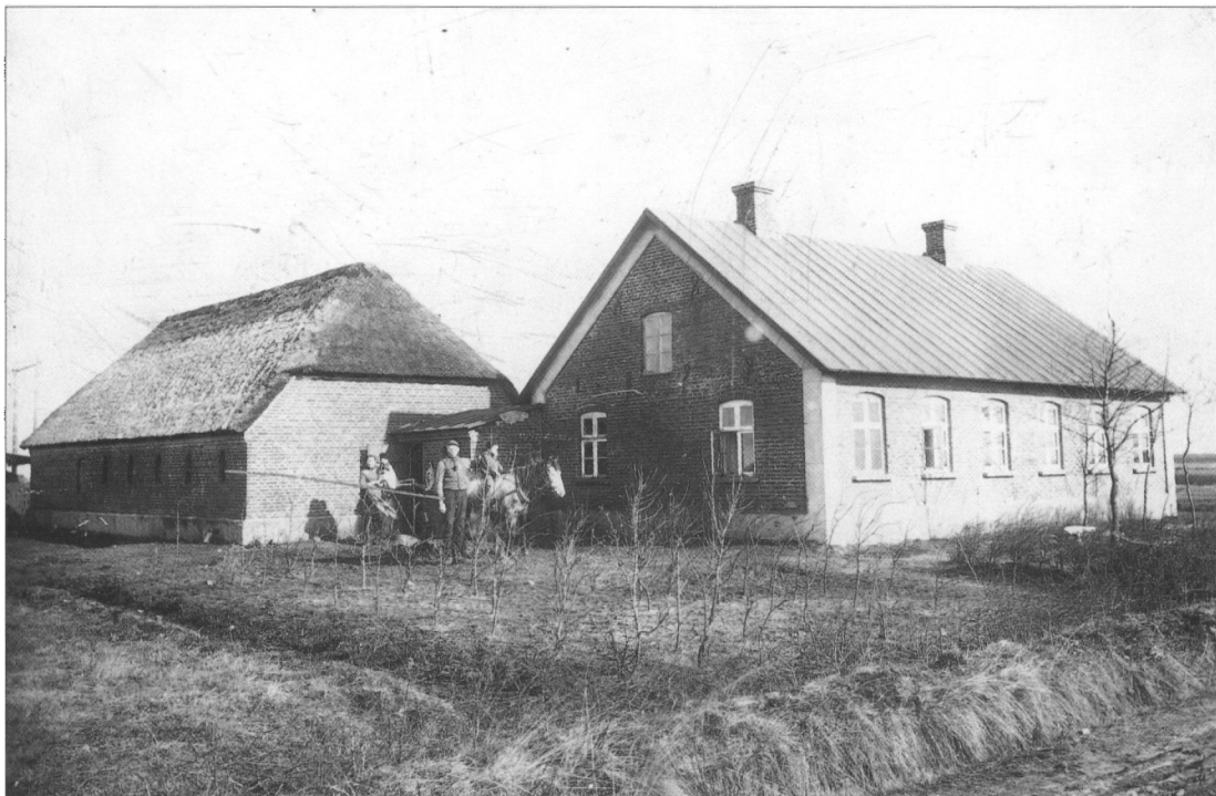
Ejendommen, Gjettrupvej 23, som Thomas Christian Jensen opførte omkring 1890 da han nedsatte sig som landmand. Foto: Astrup sognearkiv nr. 2834.
