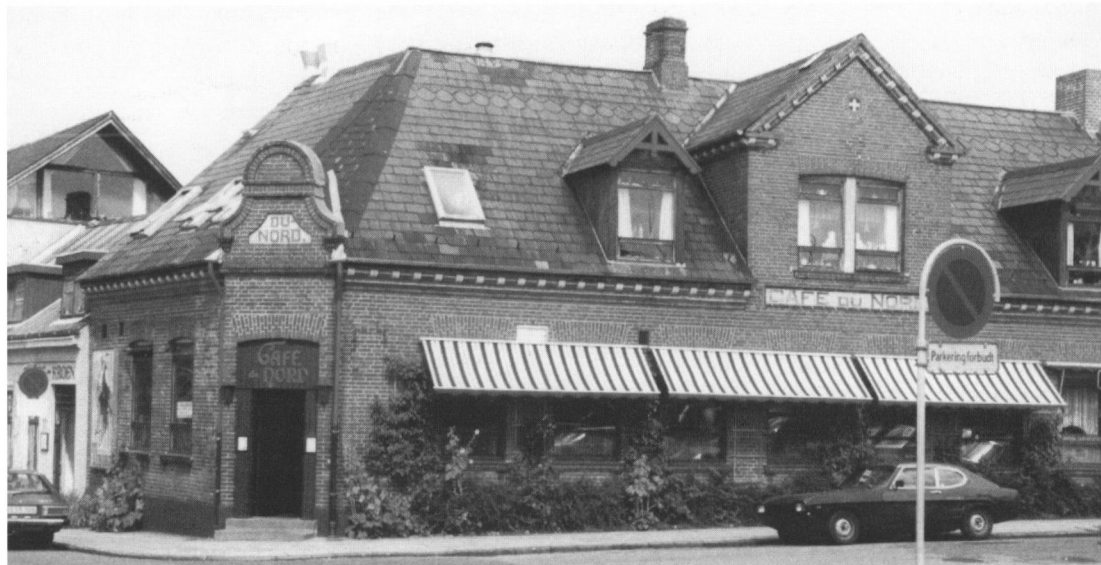
Ved Magdalene og Vilhelm Christensens store ombygning i 1911 blev huset forlænget og forhøjet med en halv etage med én stor og to små kviste. Billedet viser Café du Nord i 1975 efter en renovering med nye vinduer, døre og markiser. Foto: Esbjerg Byhistoriske Arkiv.
