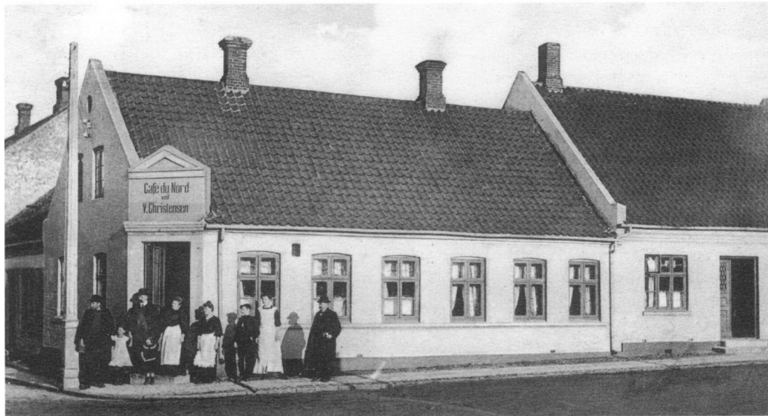
Café du Nord ca. 1907. Huset blev bygget på hjørnet af Borgergade og Smedegade i 1875 af Frands Thygesen. I 1906 købte Magdalene og Vilhelm Christensen bygningen som de ombyggede grundlæggende i 1911. De drev Café du Nord fra 1906 til 1941. Foto: Esbjerg Byhistoriske Arkiv.
