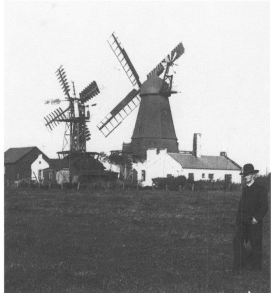
Poul la Cour på marken SØ for Forsøgsmøllen efter at det seksvingede keglevindfang var blevet afløst af et firevinget vindfang og efter opførelsen af den mellemste af de nuværende bygninger syd for møllepladsen før julen 1902.
