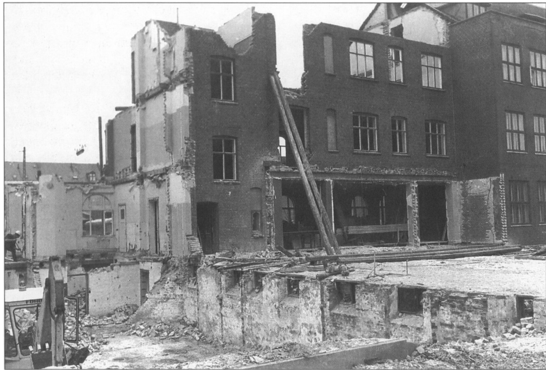
Esbjerg Kommunes gamle administrationsbygning på hjørnet af Danmarks/Torvegade under nedrivningen d. 18. oktober 1971. Foto: Knud Rasmussen. (Esbjerg Byhistoriske Arkiv. B 4.797)
