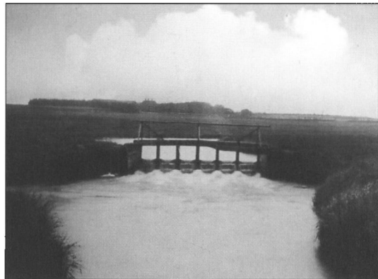
Det færdige stemmeværk – Et stighord mindre end på tegningen.
