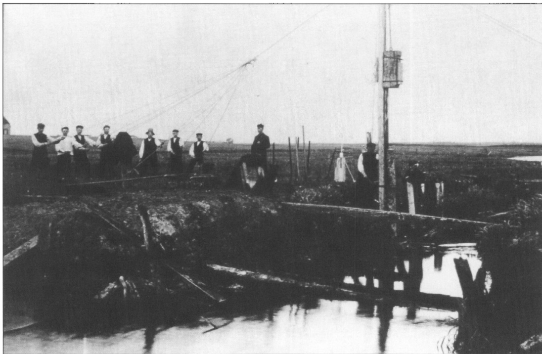
Stemmeværk under bygning øst for Grindsted. Foto 1913. Fremgangsmåder den samme som i 1869
