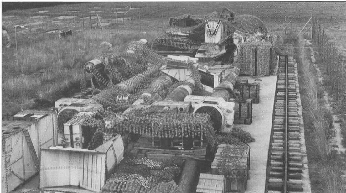
Fig. 12. De fire kanonrør oplagt på Guldager station.
