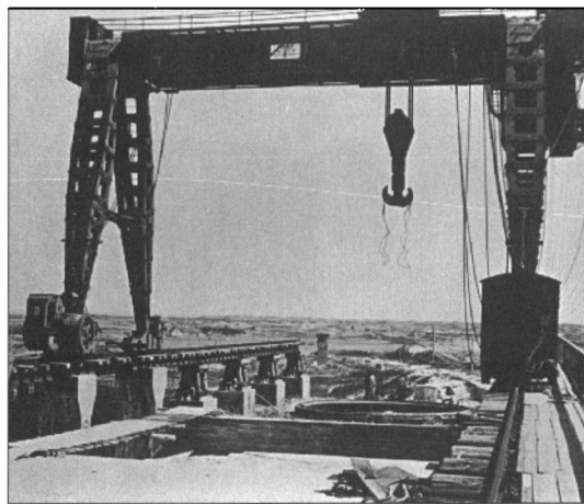
Fig. 6. Løbekran i »Tirpitzstillingen«. Løftekapacitet 175 tons.
