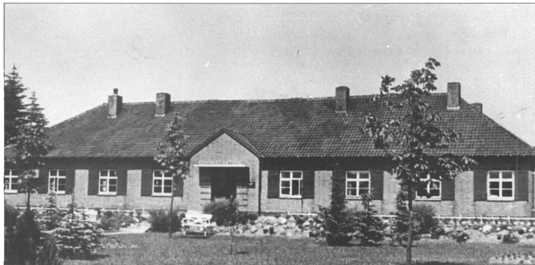
Tyskerlejrens administrationsbygning, opført i 1941, som den så ud, da det o. 1949-50 blev besluttet at bruge den som hovedbygning i den nye skole.
