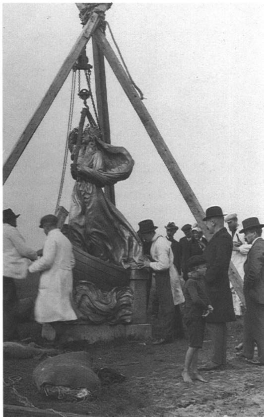
Opstilling af Dronning Dagmar-Statuen på Slotsbanken i Ribe. Under hejseværkets højre bjælke ses billedhuggeren Anne Marie Carl Nielsen. Foto i Ribe Lokalhistoriske Arkiv.
