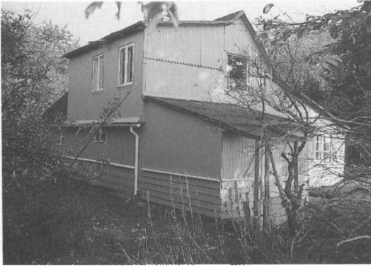
Huset set fra sydvest med den tilføjede taskekvist mod vest og tilbygningen mod syd. SMS fot. 1988
