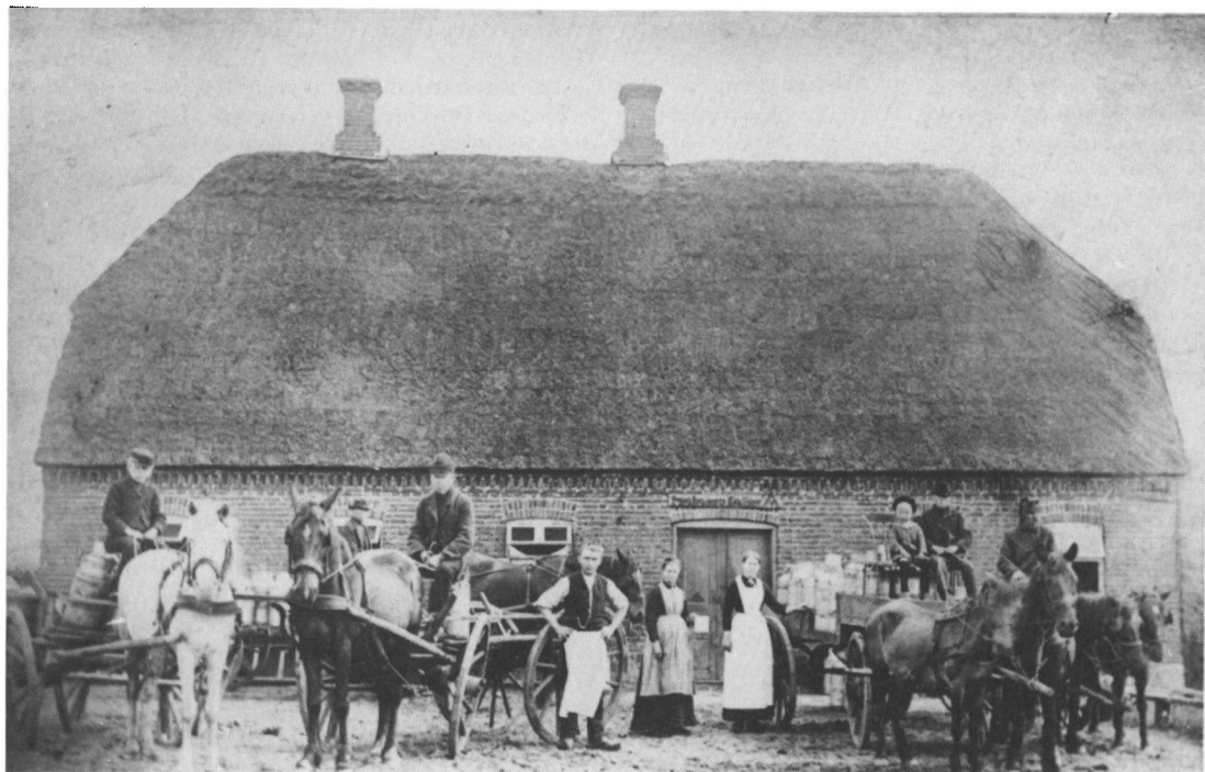
Arkivets nuværende lokaler, som de så ud umiddelbart efter opførelsen i 1884, hvor der var mejeri i bygningen. I 1939 flyttede mejeriet til nye lokaler. (Foto i Aastrup Sognearkiv).
