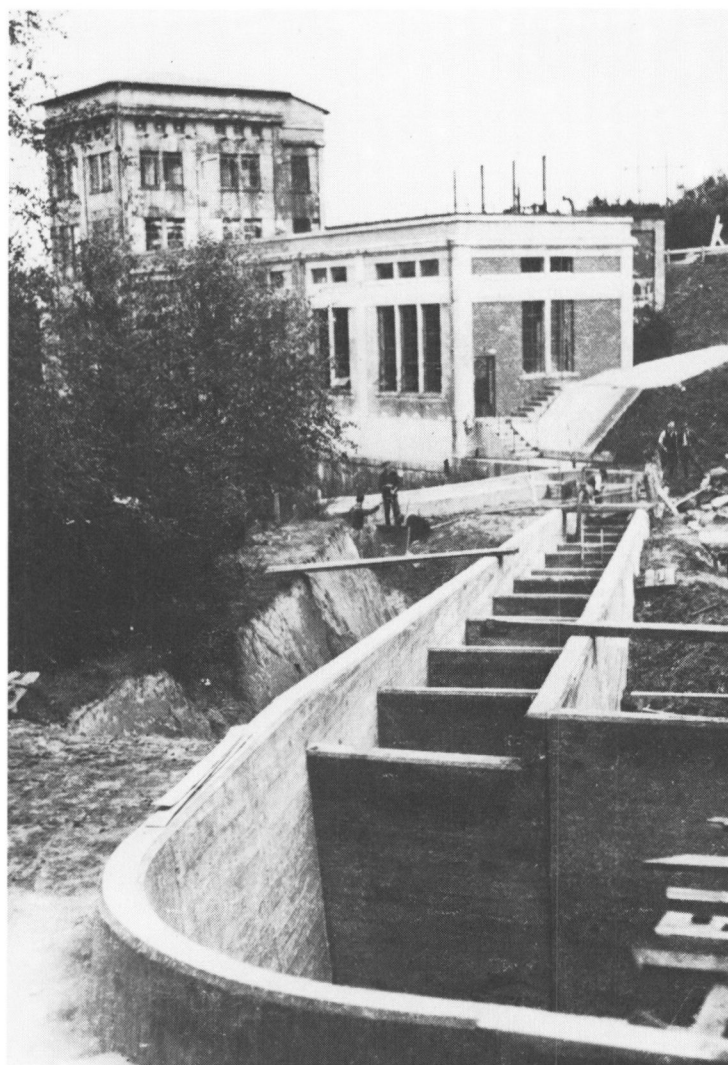
Fig. 14. Den sidste del af byggeriet ved Karlsgårde var anlæggelsen af en fisketrappe. På billedet ses en del af de 42 kamre, hvoraf tre er store hvilebassiner, hvoraf en ses i forgrunden. Foto forf.
