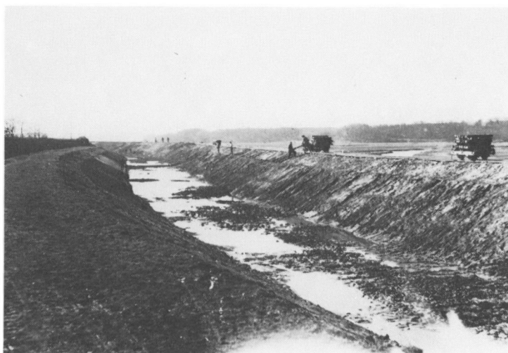
Fig. 7. Kanalarbejdet. Foto forf.
