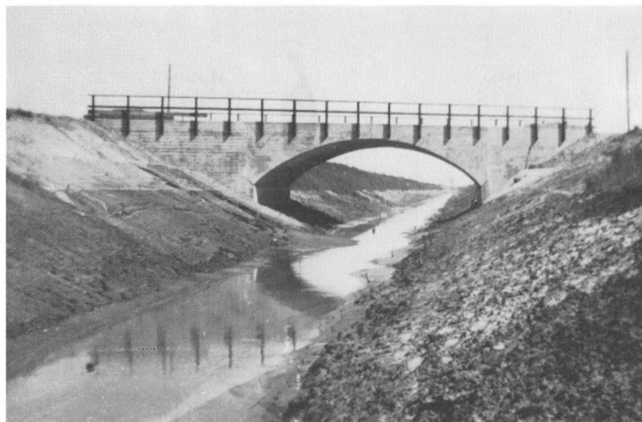
Fig. 11. En af de mange betonbroer der måtte anlægges i forbindelse med kanalarbejdet. Foto forf.
