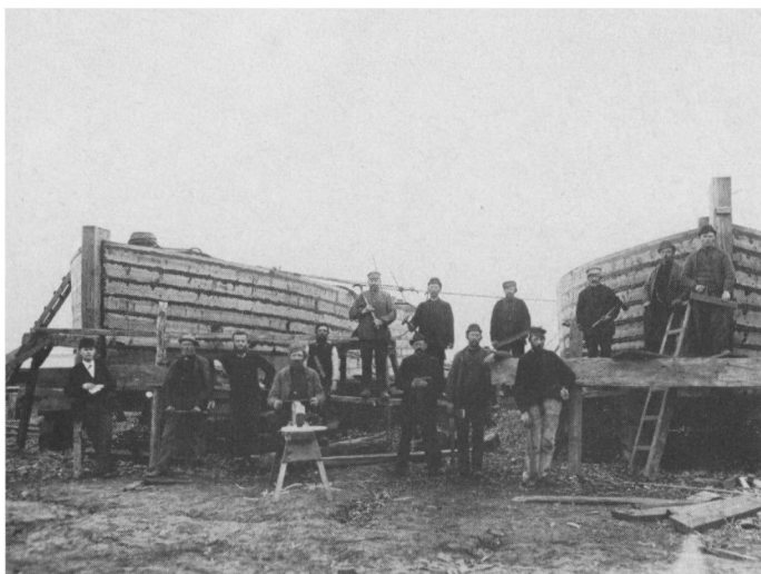
To træskibe under bygning på Th. Dahls skibsværft i Esbjerg, ca. 1898.
