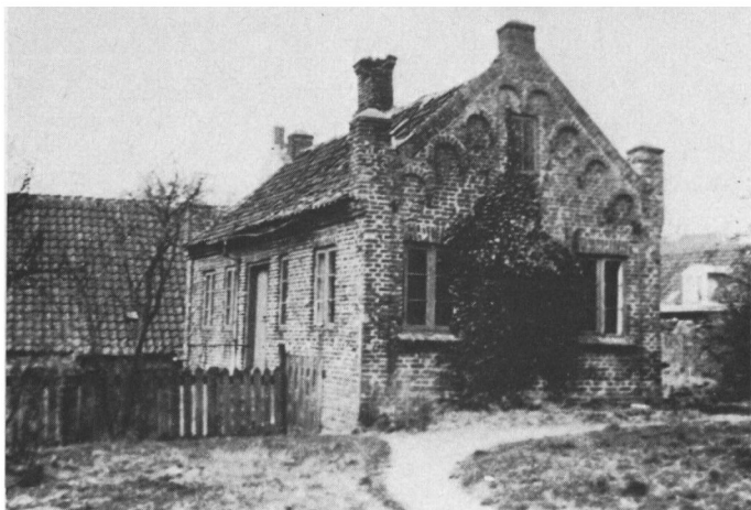
Huset, som herredsfoged C. P. T. Rosenørn lod opføre i 1853, havde fine murbuer i gavlene og fire hjørneskorstene, der iflg. bygningskommissionens forhandlingsprotokol udstyredes med såkaldte »russiske skorstenstør«. På et ældre fotografi ses i gavlen opslåede havedøre, hvorigennem der var adgang til den usædvanlig store have, der mod øst grænsede op til Arnbjerg.
