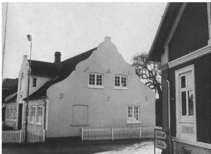
Svenskervej 12, bygget 1869. Fot. 1977 Esbjerg Museum.
