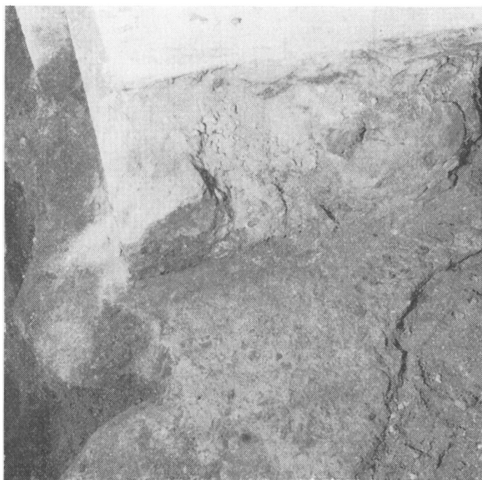
Fig. 3. Korbuens nuværende nord-vest hjørne, og spor af det oprindelige. Fra øverst til venstre i billedet kommer triumfmurens sokkel løbende ned i billedet, forbi det nuværende hjørne. Mørtelfladen ses foran muren, og den mørke stribe nederst er resterne af lergulvet.
