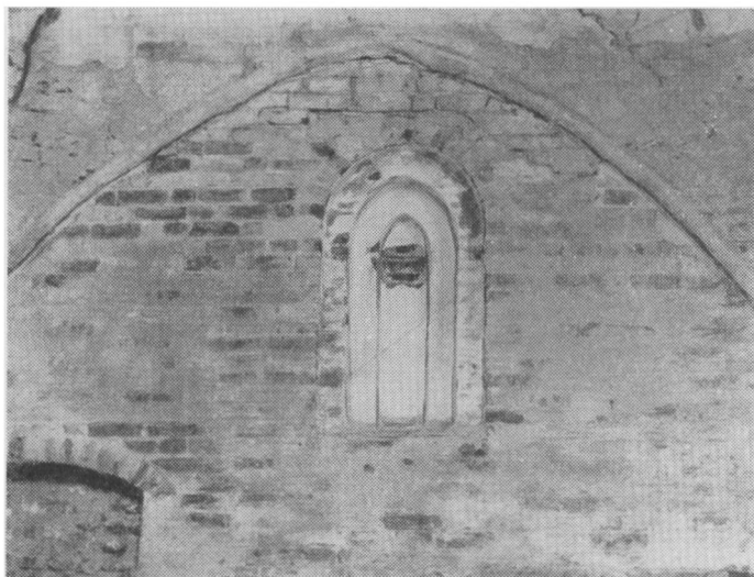
Fig. 12. Detalje af korets nordvæg til dels befriet for pudsg- og hvidtekalklag, 2 fag fra øst.
