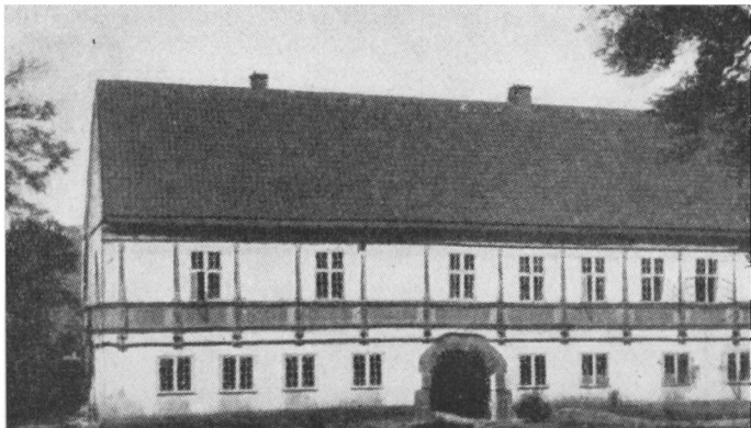
Bregninggård, opført af Hans Lange o. 1580. Bemærk den brede gesims, pilastrene og blindgalleriet.
