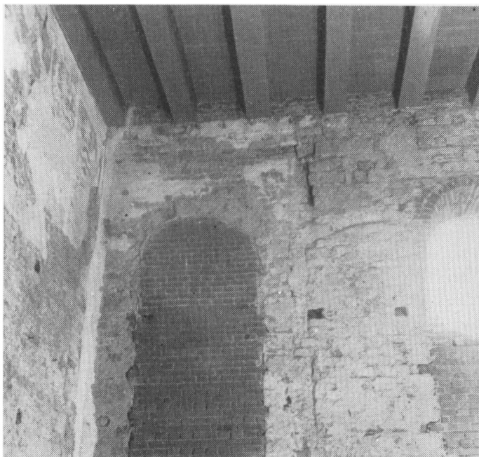
Fig. 5. Spor af Skel i Syd væggen. (Der er ikke Forbandt i Muren over det andet tilmurede Vindue).
