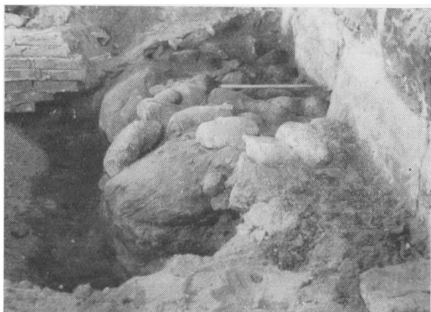
(Fig. 8). Fundamentet foran Prædikestolen. Bemærk den store Hjørnesten og de tre smaa Sten til højre ovenpaa Fundamentet, som ligger fast i Kalkmørtel af Skælkalk. Maalestokken i Billedet er 0,50 m lang.
