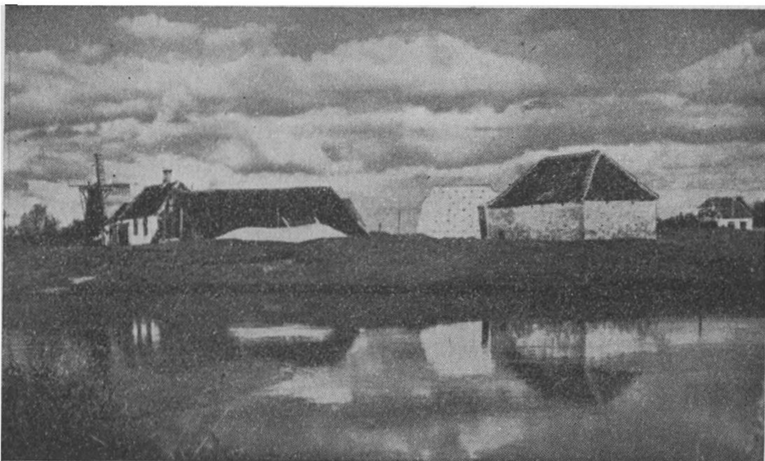
Fig. 4. Murermester Hansens Kalkovn ved Pramstedet ved Varde Aa. Den hvide Bygning med Trækkanalerne er selve Ovn. Foran staar et Oplagsrum til Klyne og den brændte Kalk; til venstre ses Fisker Chr. Muffs Hus og foran det en Dyng Skæl.
