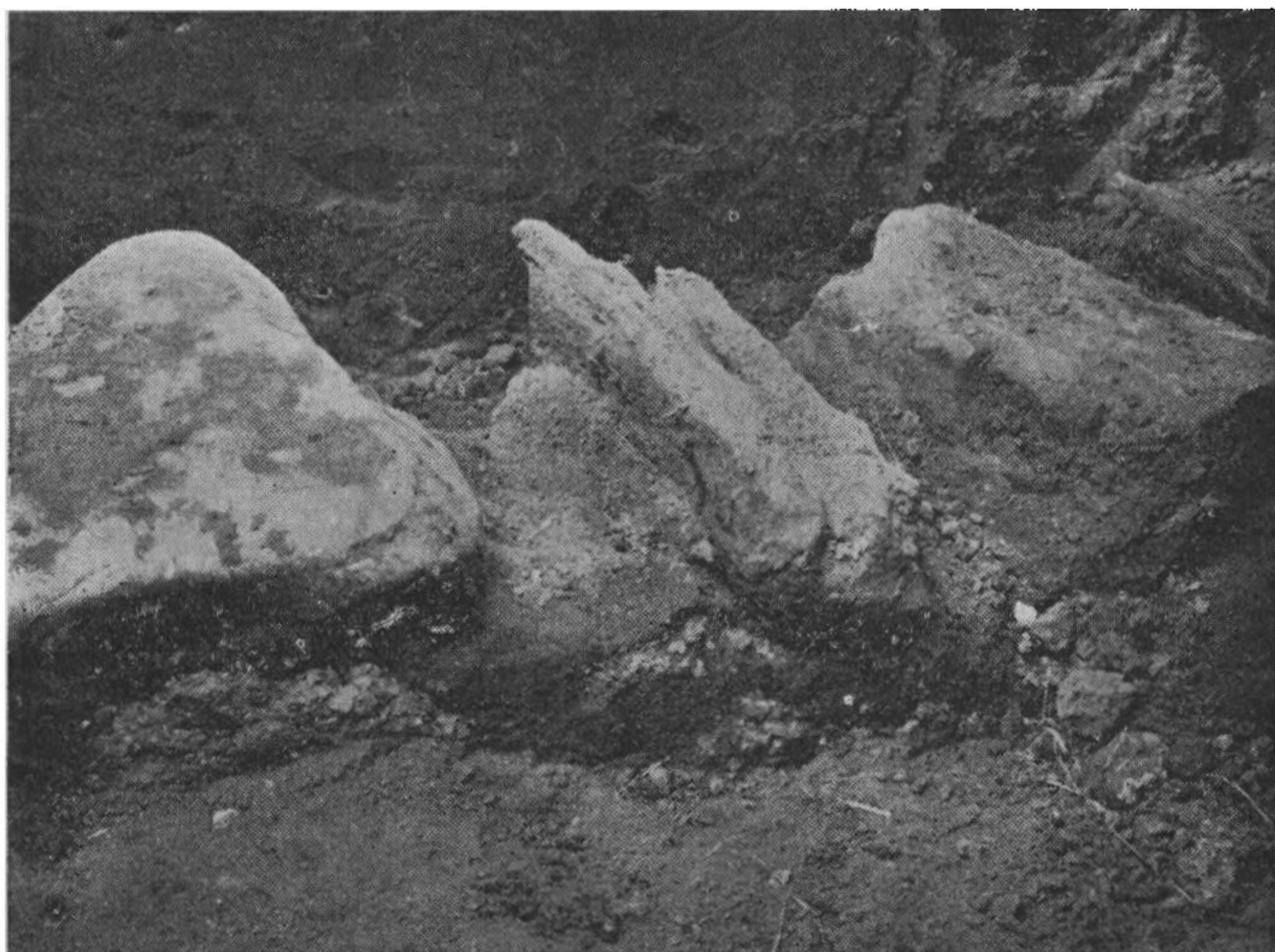
Fundamentet til Vardehus.
