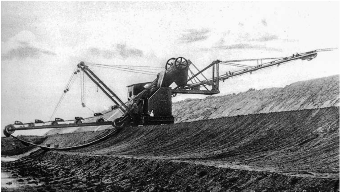
Gravemaskinen, som littede arbejdet ved den i nutiden så omtalte 'Banegrav'. GrindstedArkivet.
