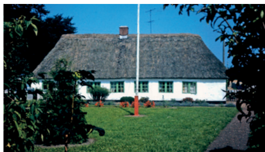
Varming Vesterby 19 i dag, hvor der er bygget flere fag til i den vestre ende. Bemærk, at vinduesfløjene er hængslede på midtersprossen på gammeldags manier.
