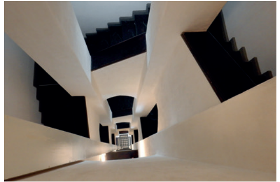
Skakten midt i fyret set fra snittet b-b. Inden der blev installeret elektricitet i fyret, blev lanteren roteret ved hjælp af et lod, der gik hele vejen ned gennem skakten. Foto: Palle Uhd Jepsen, 2018.
