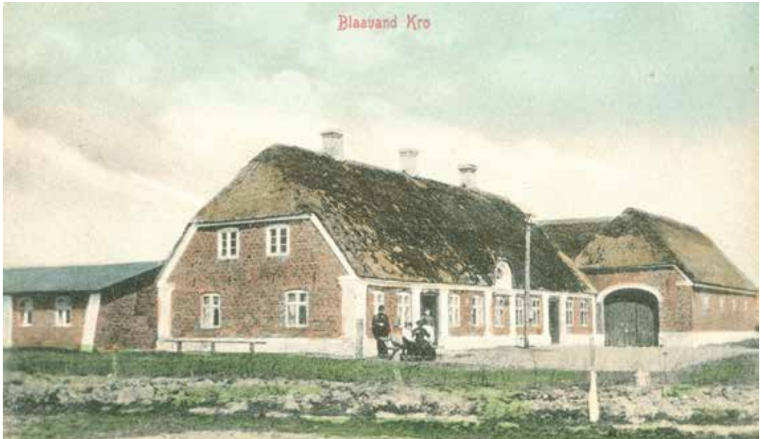
Blåvand Kro blev opført i 1878 for at kunne betjene det stigende antal sommergæster. Postkort fra før vestfløjen blev bygget mellem 1910 og 1915. Blåvandshuk lokalhistoriske Arkiv.
