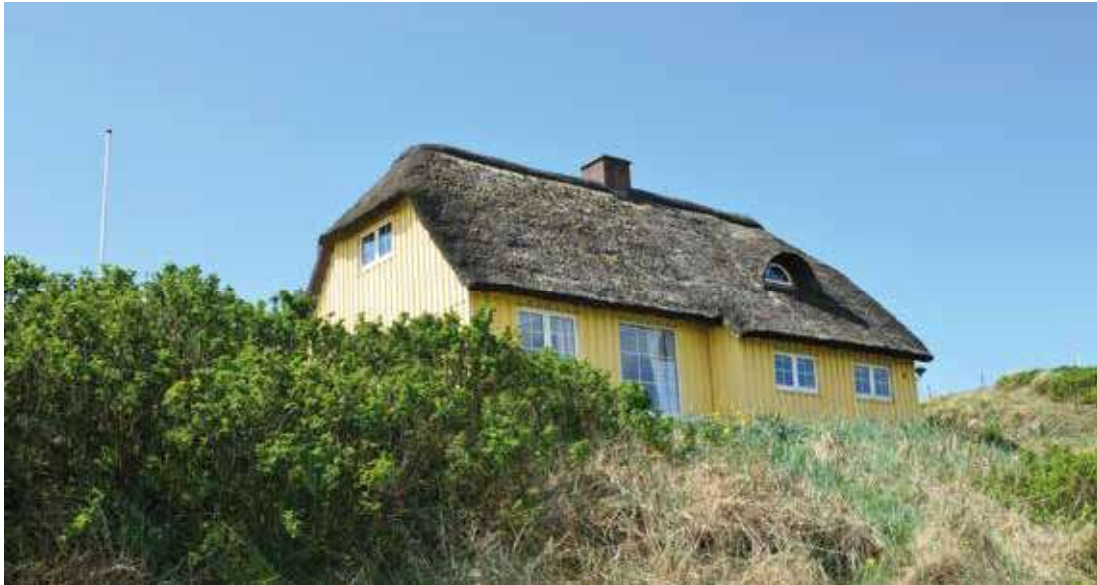
Sommerhuset er i dag beklædt med brædder efter en modernisering, men hedder stadig Bindingsværkshuset. Foto: Torben Christiansen.
